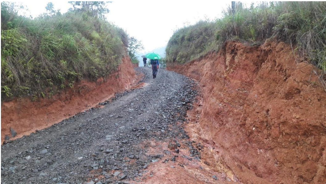
Ingreso a la comunidad, camino en proceso de lastero
