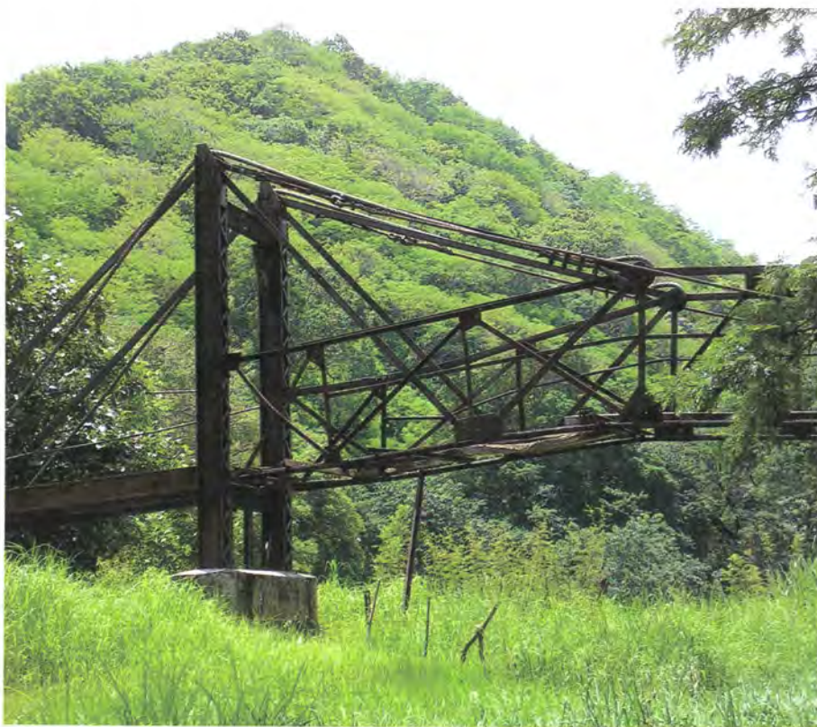
Figura 6. Puente Metálico ubicado en la comunidad de Bolsón, construido en 1927.
